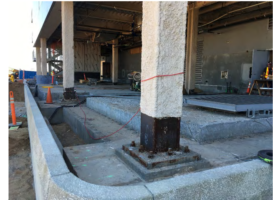
Preparation for Sidewalk Pour
